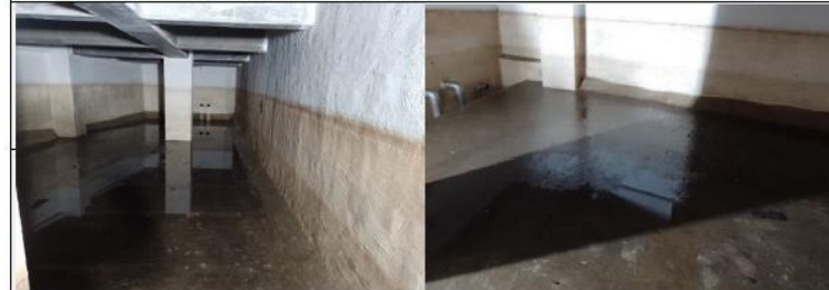
TANQUE 2 SUBTERRANEO - AGUAS LLUVIAS
