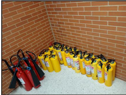
Recarga de extintores
