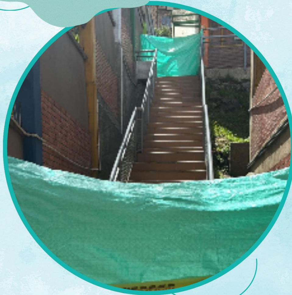
Cubierta de las escaleras
